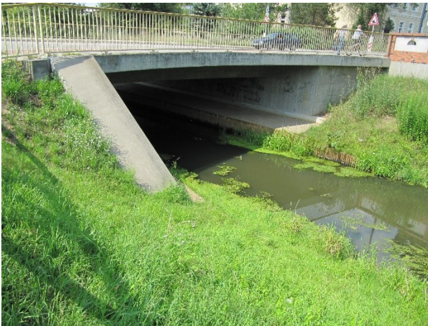
Foto 1: Freienwalder Landgraben Brücke
